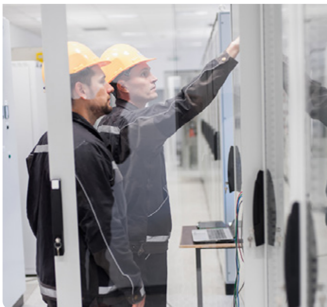
Konstruktorzy tablic elektrycznych
