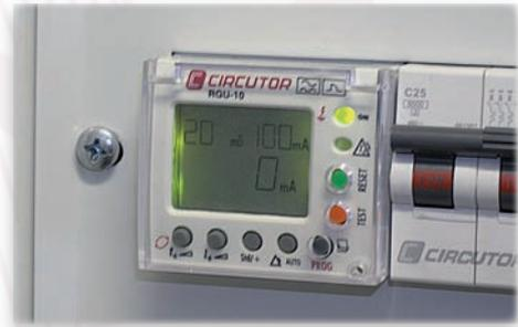
Por tanto, convierten la protección diferencial en un equipo de medida de corrientes de fuga y como tal, en un equipo integrable en un sistema de supervisión de energía y proceso.
