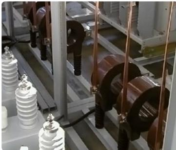
La conexión de baterías de condensadores lleva asociado transitorios de tensión y corriente elevados. La **Norma** internacional **IEC 60871-1** define el valor máximo que una batería de condensadores es capaz de soportar como valor de pico de conexión. Este valor de pico debe quedar por debajo de 100 veces la intensidad nominal de la batería o escalón que se maniobra.
