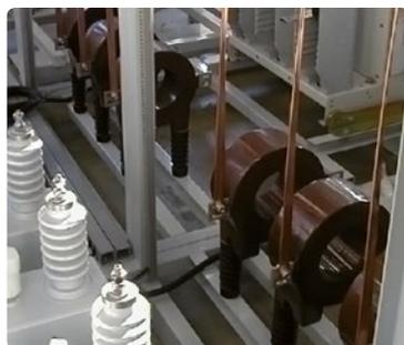
A ligação de baterias de condensadores está associada a transitórias de tensão e corrente elevadas. A Norma internacional CEI 60871-1 define o valor máximo que uma bateria de condensadores é capaz de suportar como valor de pico de ligação. Este valor de pico deve situar-se abaixo de 100 vezes a intensidade nominal da bateria ou escalão que é manobrado.
