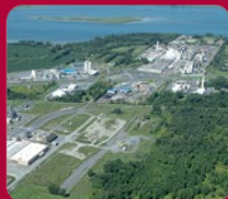
Stations de pompage
