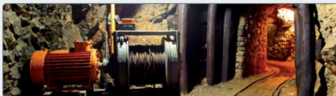
Installations avec des points de mesure mobiles / Applications distantes
